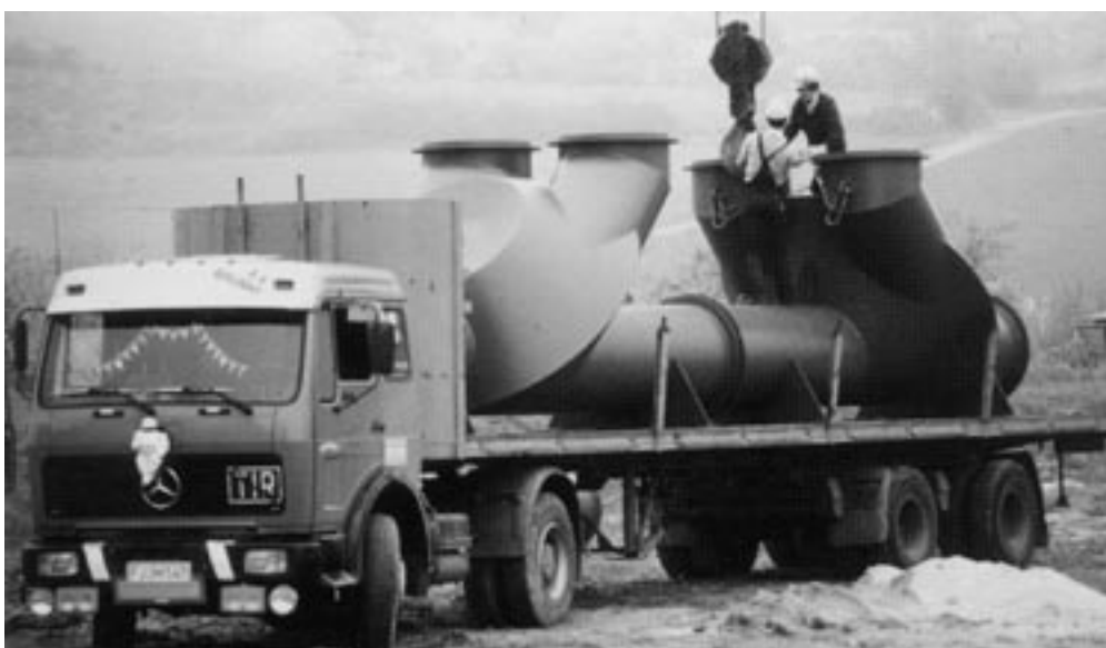
Fig. 4 : Transport sur site des deux régulateurs vortex commandés FluidTriode pour équiper le bassin de retenue.
