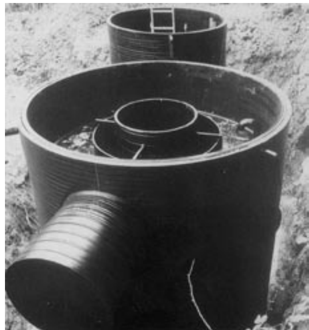
Fig. 3 : Séparateur vortex en PEHD avec regard de régulation à l'arrière plan.
