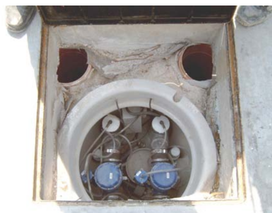
Chambre de collecte double avec 2 unités d'interface
