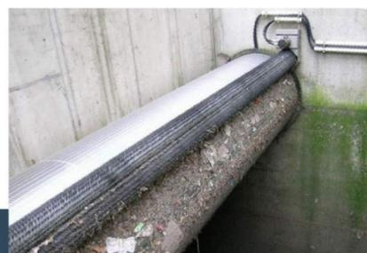
Tamis filtre rotatif Fluidrotor TDF 0234
